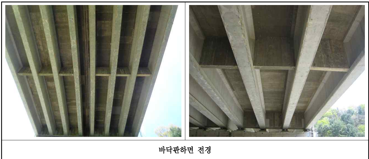
【사진 6.3.2】 바닥판하면 전경
