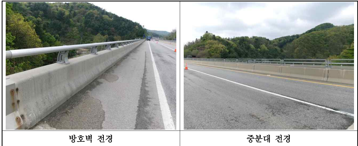
【사진 6.3.23】 방호벽 및 중앙분리대 전경
