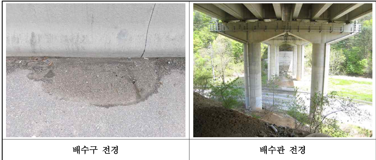
【사진 6.3.21】 배수시설 전경
