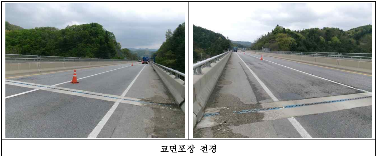
【사진 6.3.19】 교면포장 전경
