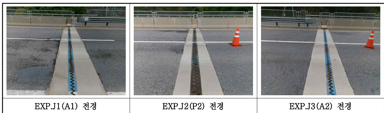
【사진 6.3.16】 신축이음장치 전경
