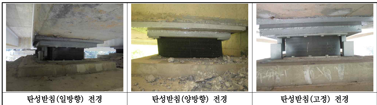
【사진 6.3.12】 교량받침 전경
