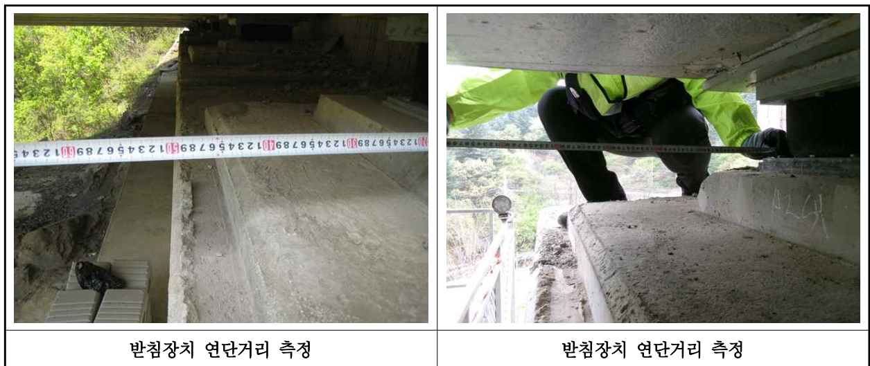
【사진 6.3.14】 교량받침장치 연단거리측정
