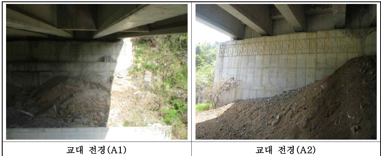
【사진 6.3.8】 교대 전경
