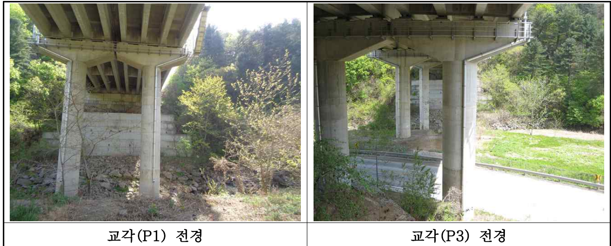
【사진 6.3.10】 교각 전경
