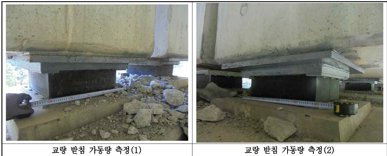
【사진 6.3.15】교량받침 이동량 측정
